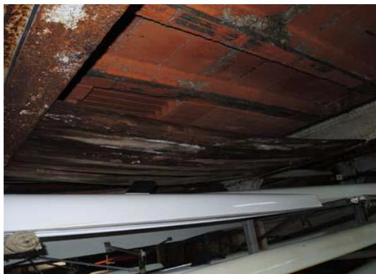
*Dalle non étanche, chute de briques sur les bateaux, risque d'effondrement*
