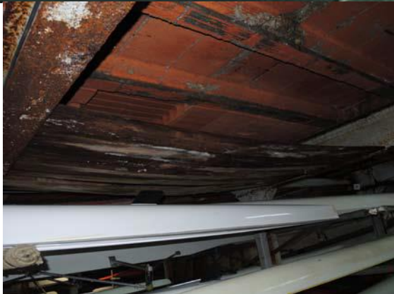
Dalle non étanche, chute de briques sur les bateaux
