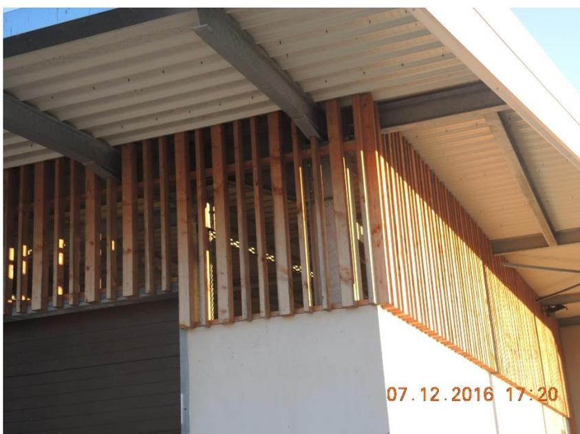
A noter que la solution retenue des claies en bois sous le toit (circulation d'air en partie supérieure, gage d'un stockage au sec, présente l'énorme inconvénient d'être aux courants d'air, très froids et de servir de nichoir aux oiseaux, avec les déjections qui vont avec et qui ne font pas bon ménage avec les coques des embarcations.
